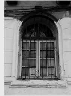
F. ORNAMENTOS EN VENTANAS
