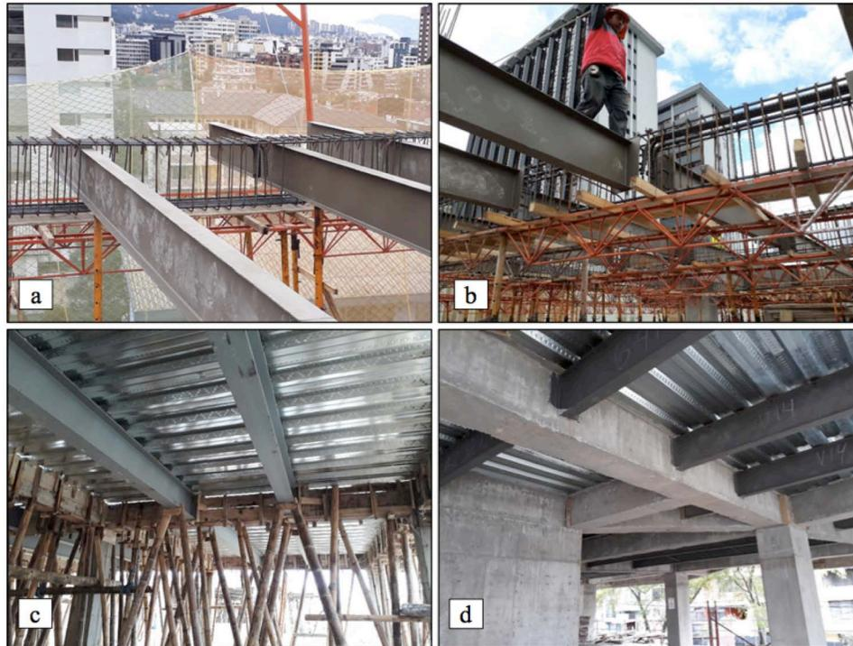
**Figura 1.** Nudos híbridos. a) perfil I pasante, b) perfil I anclado, c y d) losa steel deck
