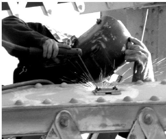
Figura 3. Instalación de platinas con soldadura.
