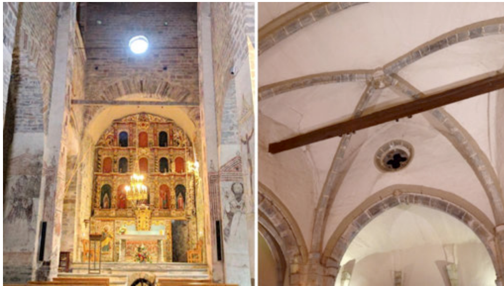
Figure 11. Timber tie beams a) Santa Maria de Cap d'Aràn de Tredós; b) Sant Joan d'Arties
